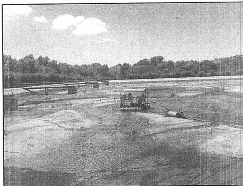
Figura 3 - Bombeamento com bomba submersível sobre balsa
